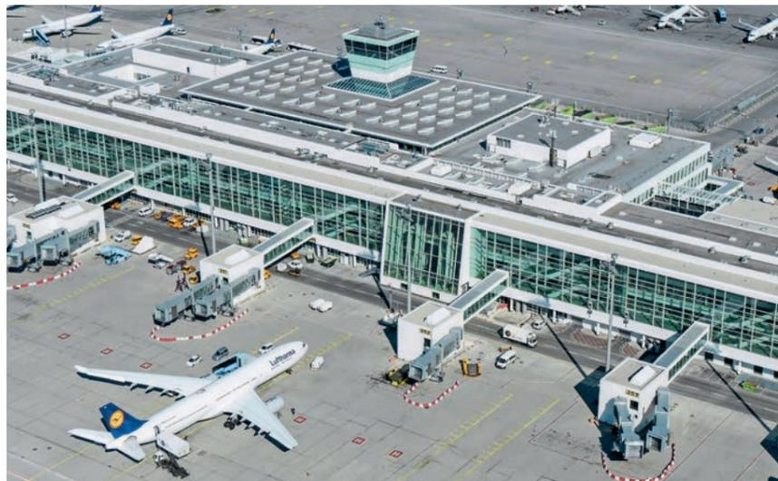
Die Glasfassade des Satelliten verbindet zeitgemäße Ästhetik mit hervorragender Energieeffizienz: Das neu entwickelte Glas sorgt für lichtdurchflutete Räume, verhindert aber wirksam ein ungewolltes Aufheizen des Gebäudes.
